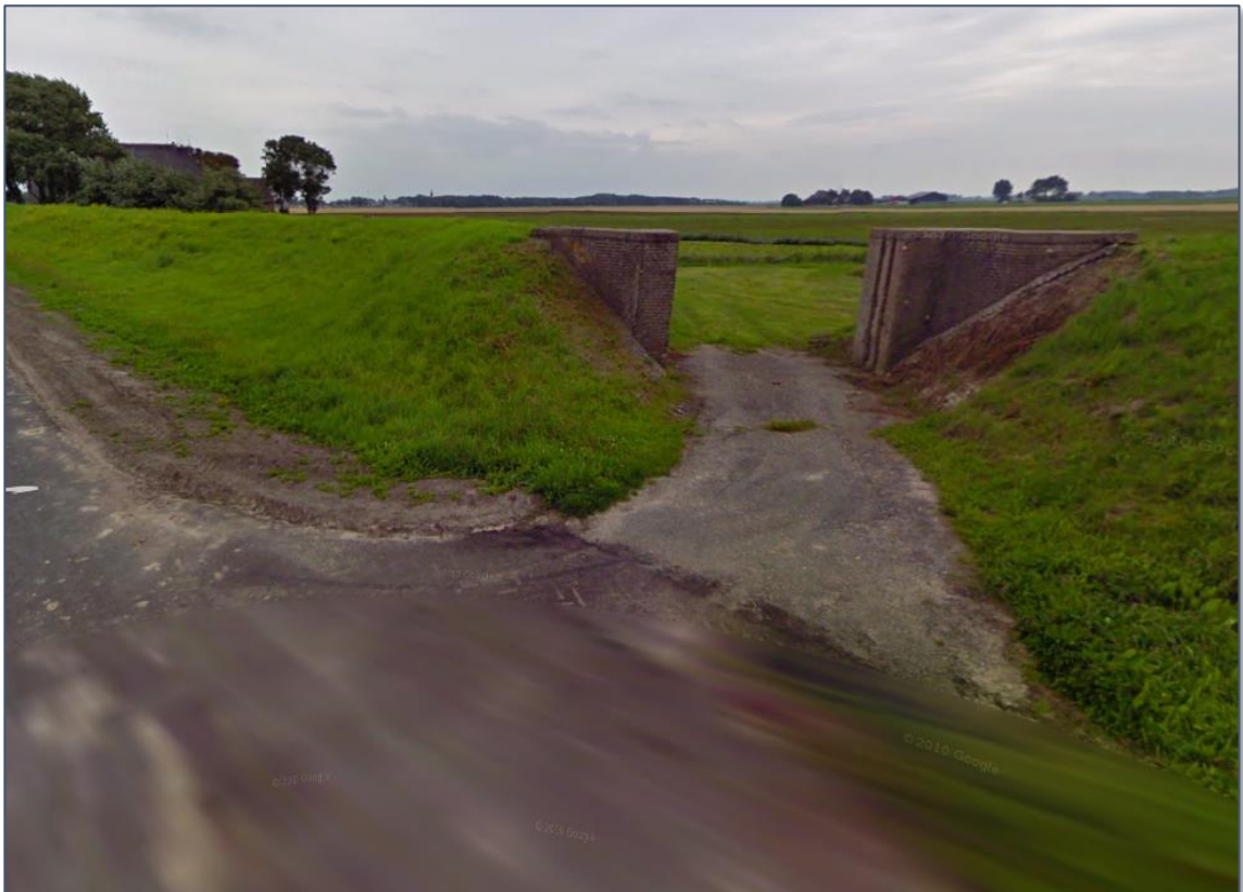
Coupure naar een gemaal, ongeveer halverwege de Alddyk met verplaatsing van het schotbalkenhuisje naar wegzijde met bijpassend informatiepaneel.
